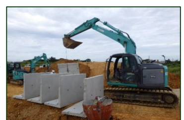
現場荷卸し状況
