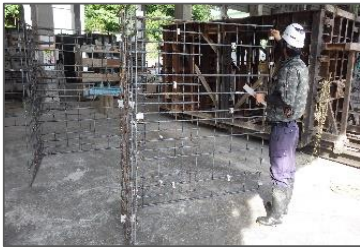
配筋検査状況
