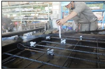
型枠かぶり検査状況
