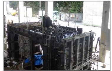
型枠組立状況
