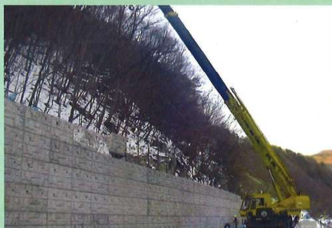
14. ブロック積上げ (NB1・2ブロック)
