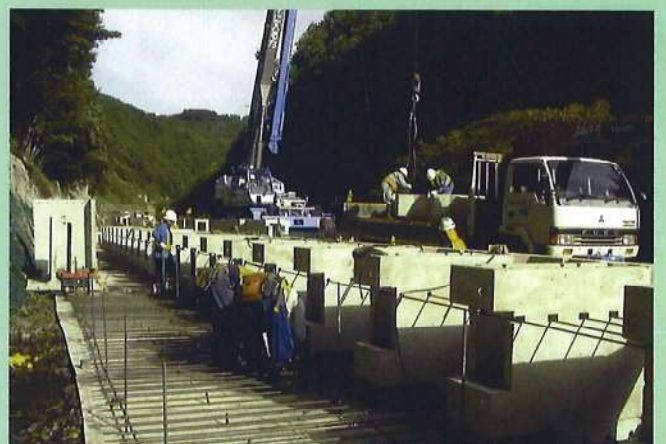
6. 底版鉄筋組立
