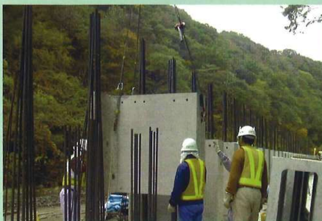
10. ブロック積上げ (D2ブロック)
