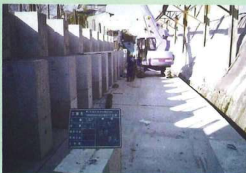
小型クレーンによるブロック据付
