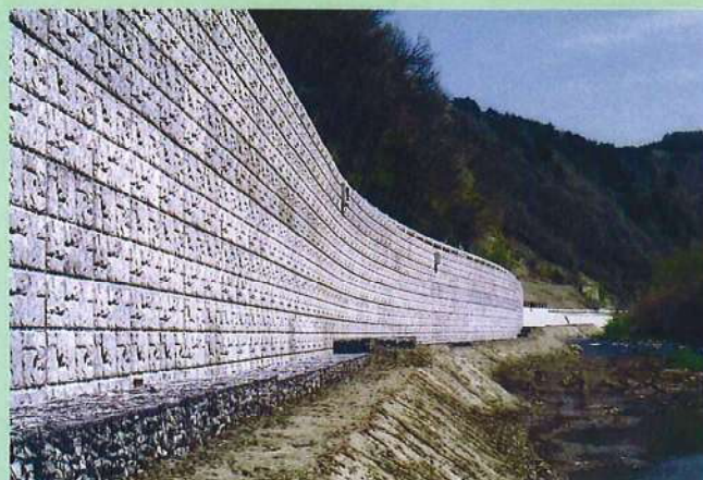
16. ブロック積上げ完成
