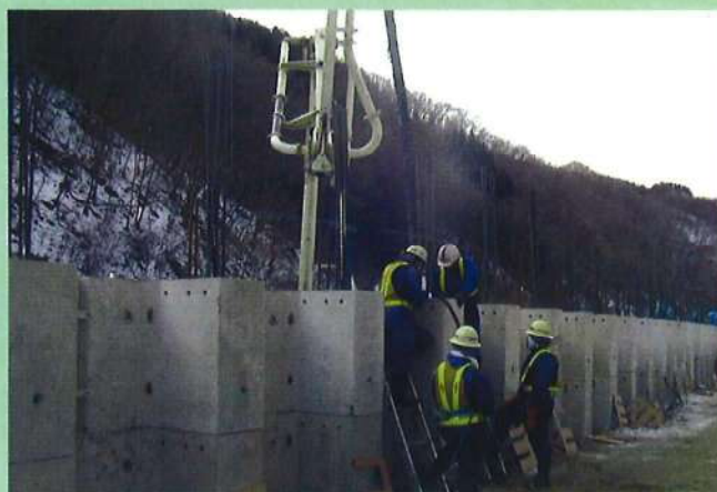
13. ブロック胴込めコンクリート (C1・2ブロック)
