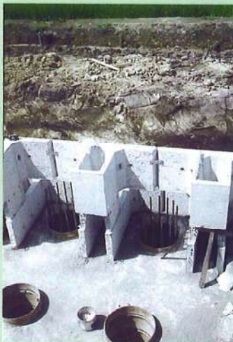
フーチング部杭頭処理
