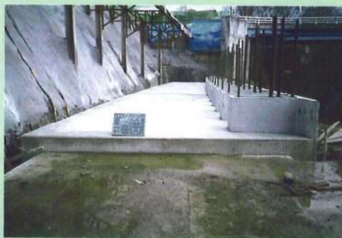
フーチングコンクリート打設
