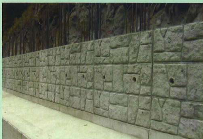
11. ブロック積上げ全景 (D2ブロック)
