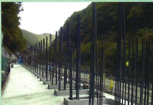
9. 底版コンクリート完成
