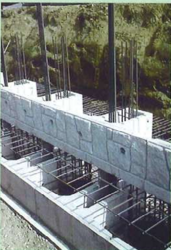
フーチング配筋
