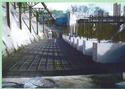
フーチング部配筋
