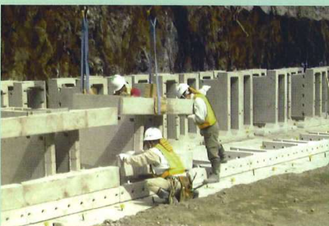
4. 基礎ブロック積上げ (S4・D1ブロック)
