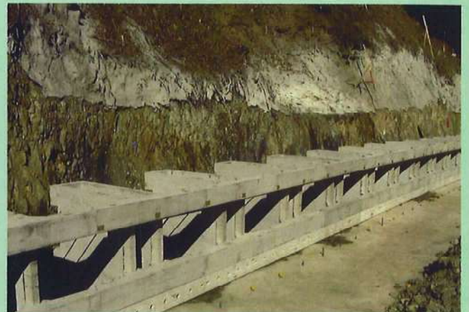
5. 基礎ブロック積上げ完成 (S1・D1ブロック)
