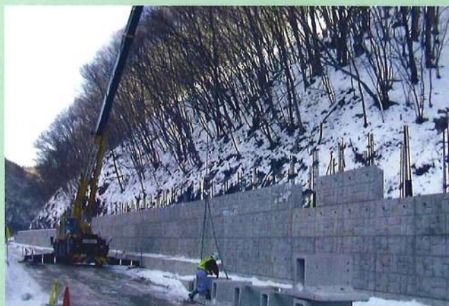
12. ブロック積上げ (C1・2ブロック)
