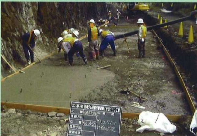
2. 均しコンクリート打設
