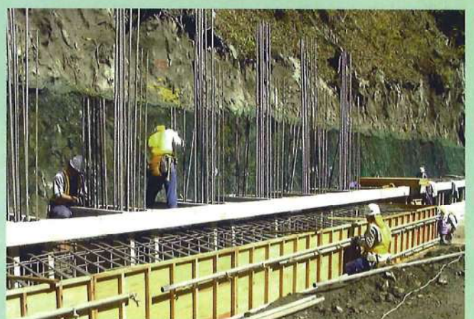
7. 底版型枠組立
