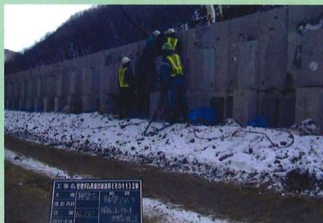
15. ブロック胴込めコンクリート (A・Bブロック)
