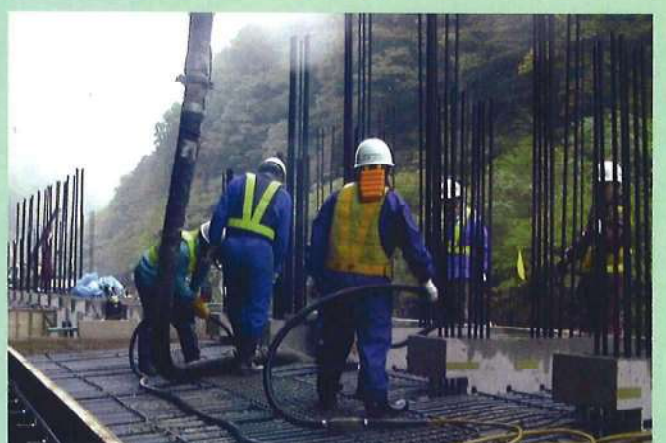
8. 底版コンクリート打設
